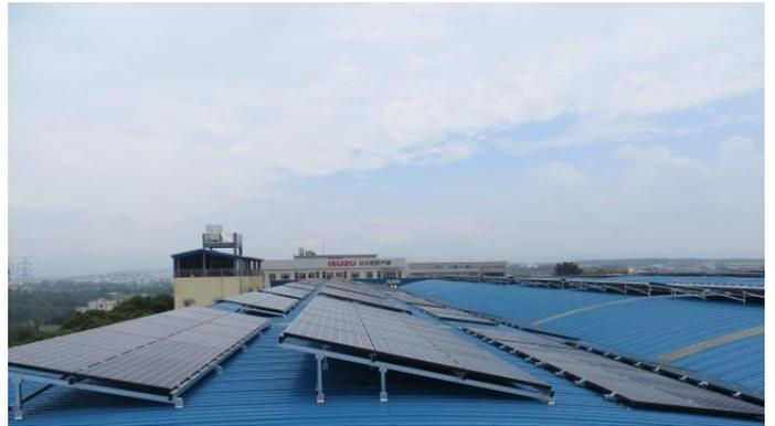
**屋根の高さに合わせて架台の高さを調整する**
