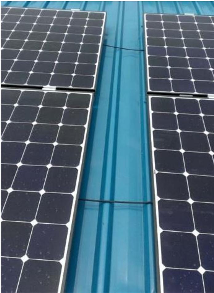
**パネルの間に間隔を取る**
