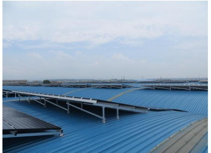
**屋根の高さに合わせて架台の高さを調整する**
